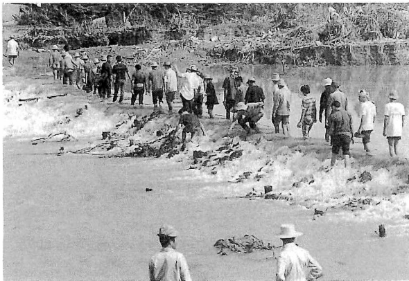
ピン川（タイ国）の井堰処理作業
