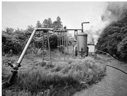
写真1 配湯設備（堀田）
