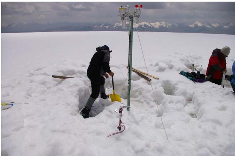
標高4700mの氷河頂上に自動気象測器を設置する
