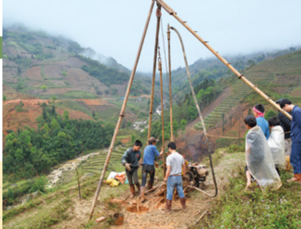
ベトナム・ラオカイにおける地すべり調査のようす。地下水位モニタリングセンサー設置のためのボーリング作業
