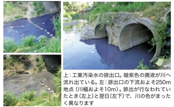
上:工業汚染水の排出口。暗紫色の廃液が川へ流れ出ている。左:排出口の下流およそ250m地点(川幅およそ10m)。排出が行なわれていたとき(左上)と翌日(左下)で、川の色がまったく異なります
