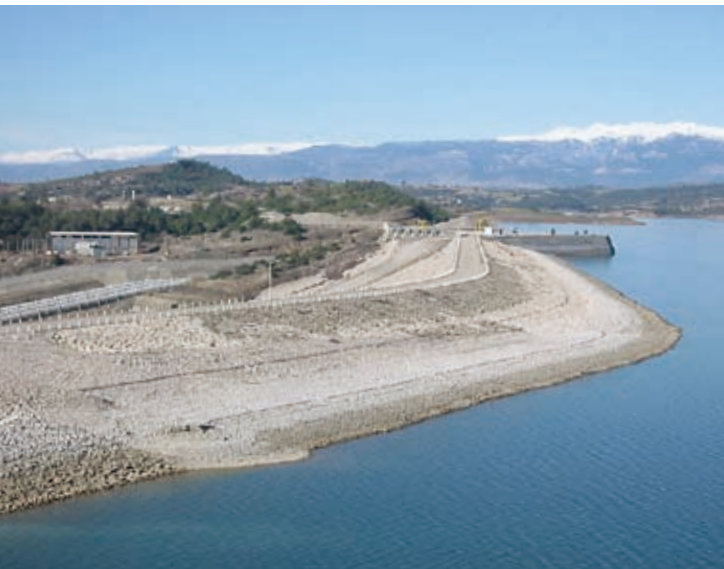
トルコ・セイハン川のチャトラングダム(貯水総量16億m 3 )。冬の雪融け水を貯水して、下流で灌漑用水・都市用水として使う
