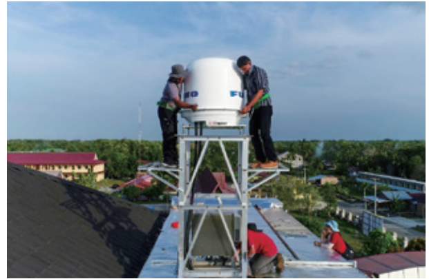
写真2：気象レーダーの設置（ブンカリス県、2020年2月12日）
