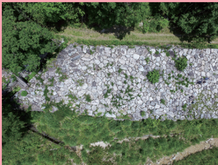
写真2：滋賀県大津市の百間堤（ひゃっけんづつみ）。長さ約180mの石塁で、土砂災害を防ぐために江戸時代に作られた。地域の自然資源を利用したEco-DRRの一つと位置付けられる。（Eco-DRRプロジェクト）
