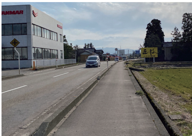
写真1-2 富山県道25号砺波細入線整備後の様子（2021年4月）
