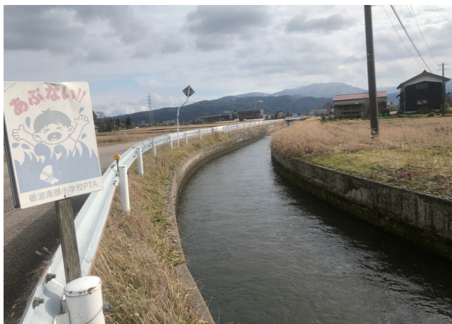
写真 4 整備された水路 (2020年2月)
