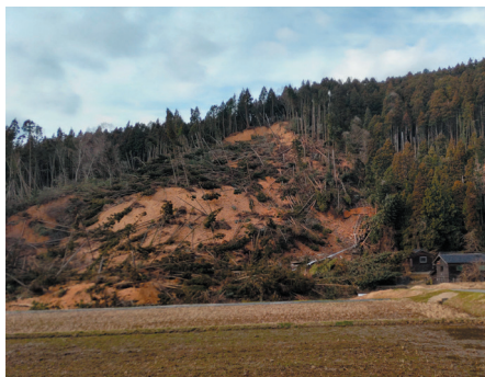
写真31 豪雨により発生した地すべり
