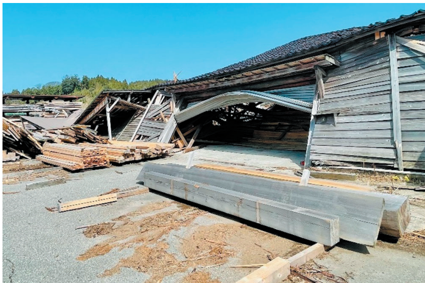
令和6年能登半島地震で倒壊した製材所倉庫林
