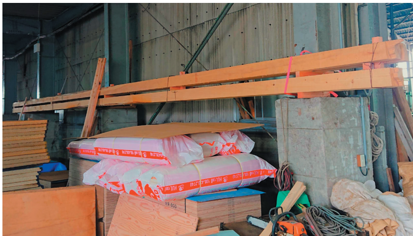
写真6 2026年新造に向けて乾燥中のアテ材。珠洲市の船本工務店にて。
