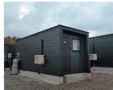
写真 34 仮設宿泊所（輪島塗仮設工房と同型）
