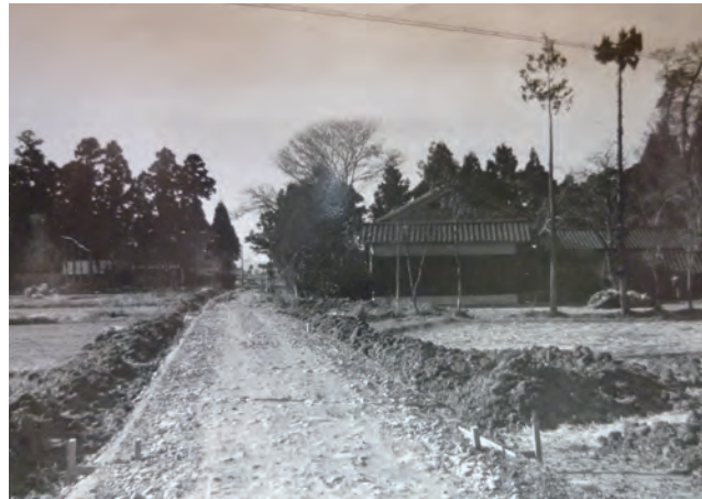
写真2 村道工事途中の様子（昭和30年代 写真提供：中島勝利）
