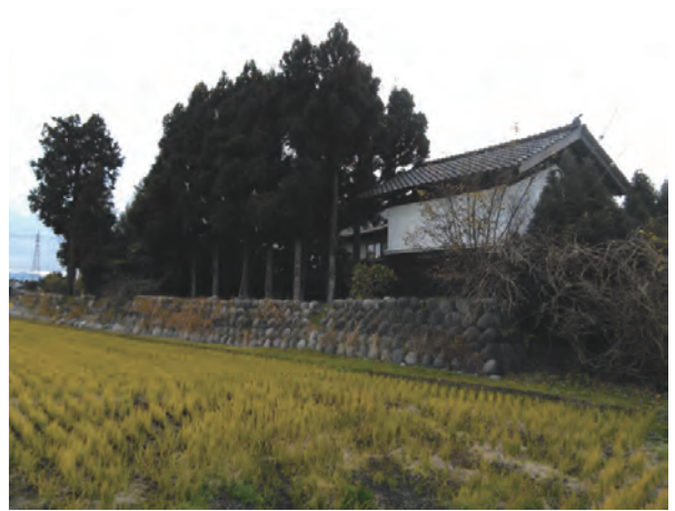
写真6 大きな石垣の家
