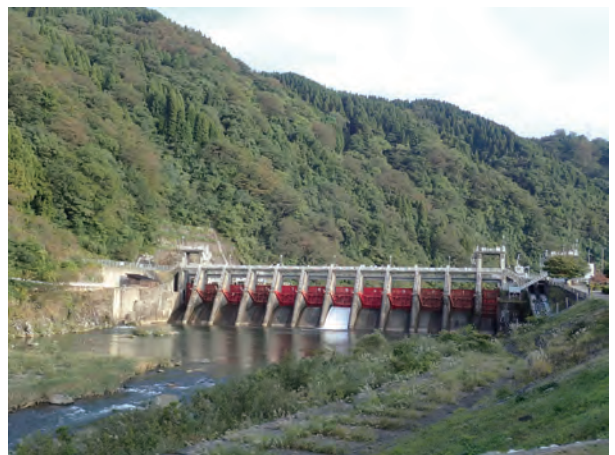
写真2 現在の庄川合口堰堤（2021年10月24日 写真提供：Eco-DRRプロジェクト）
