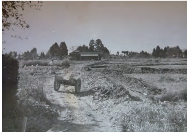
写真1 村道工事の様子前（昭和30年代 写真提供：中島勝利）
