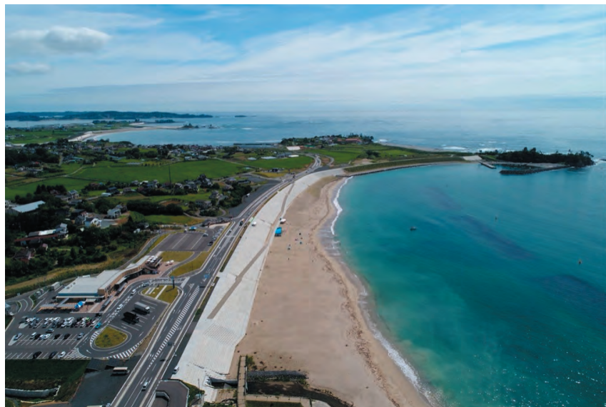
写真1 防潮堤をセットバックした宮城県気仙沼市の大谷海岸（2022年8月）
