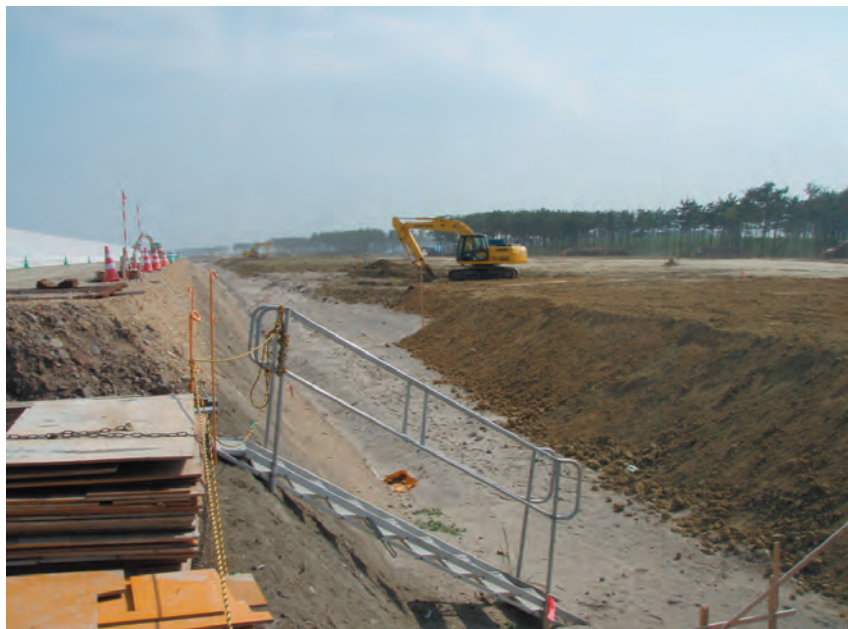
写真1 進む防災インフラ工事
