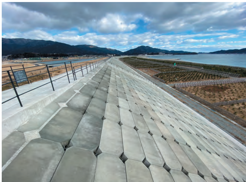
陸前高田市高田松原の堤防
