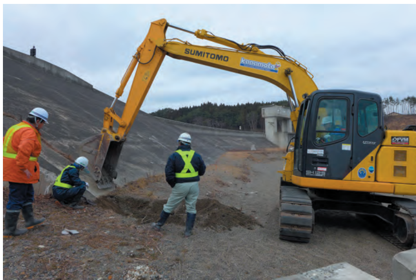
写真2 バックホーによる海浜植物の掘り取り作業（野田村十府ヶ浦 2015年1月）
