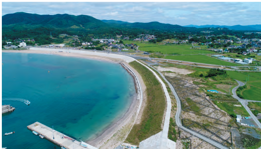
写真 4 防潮堤法面を覆砂により緑化した三島海岸（左奥に大谷海岸が見える）
