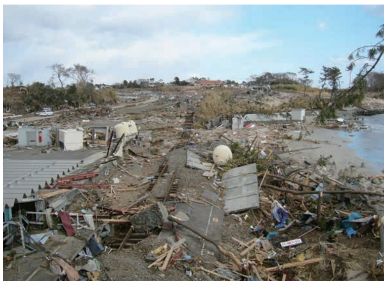
写真 9 東日本大震災の被害 (気仙沼市内)
