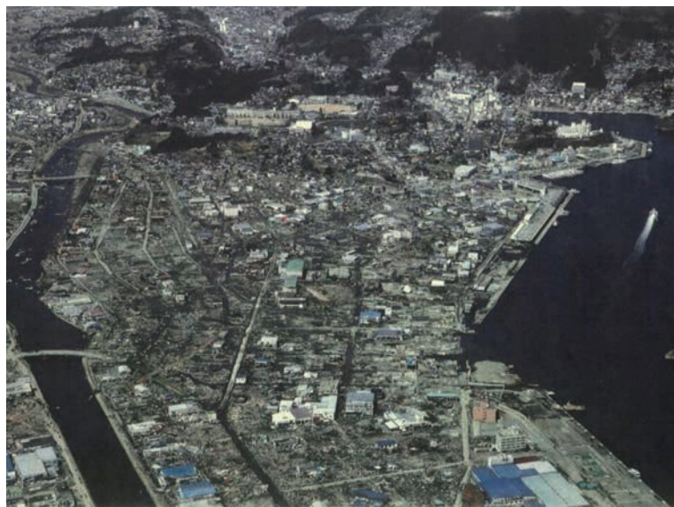
写真7 東日本大震災の被害（気仙沼市内）
