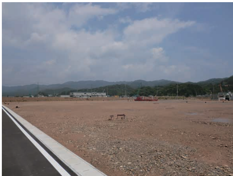
写真 13 区画整理・住宅整備予定地 (2015 年)
