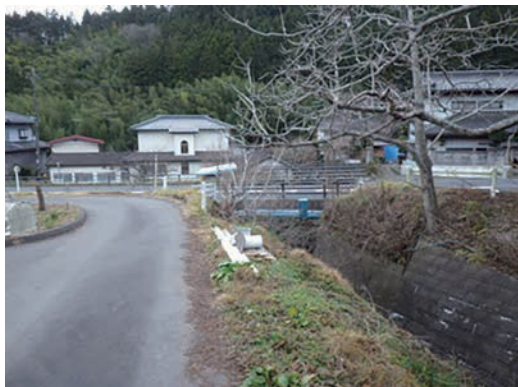
写真 2 荒町の土石流危険渓流出口に建てられた新築住宅
