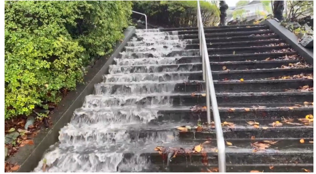
図16 花の木公園から道路への流出の状況 (2022年9月18日)
