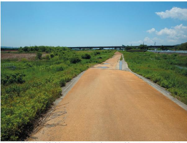
図1 遊水地の越流堤。周辺の堤防よりも低くっており洪水の時は河川の河道（右側）から遊水地内（左側）に水が入る
