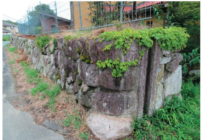
写真7 荒川地区の土砂災害対策を併用したシシ垣
