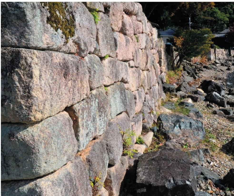
写真1 海津・西浜の石積み（切石が多く使われる部分）
