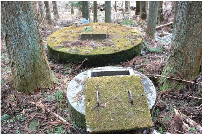
写真5 取水口の下流直下にある沈殿槽
