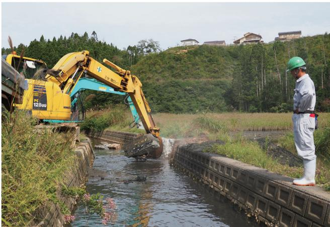
写真10 河川護岸の開削 (2021年9月)
