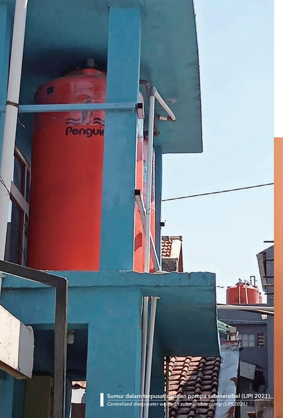
Sumur dalam terpusat dengan pompa submersibel (LIPI 2021)
