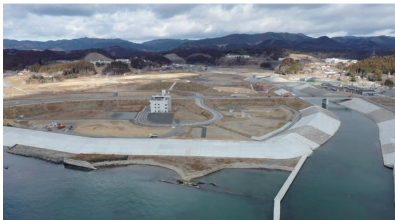
防潮堤・河川堤とセットバックにより保全された松原海岸
