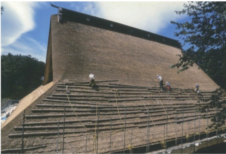
日本一の茅葺き屋根の仕上げ作業（岩手県奥州市）（提供：熊谷産業）
