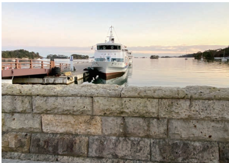
松島湾船着場付近の石積み防潮堤
