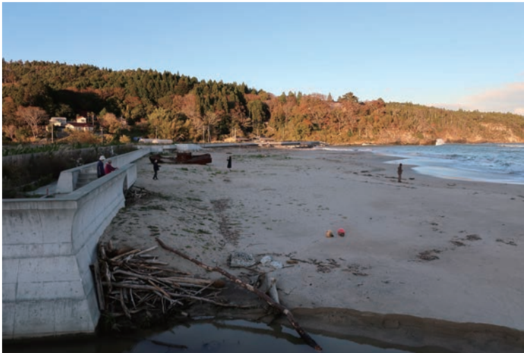
田中浜（地盤沈下した浜の防潮堤を１メートルだけかさ上げて元の高さに戻す復旧にとどめた。）（提供：渡辺網男氏）
