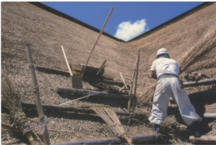
茅葺き屋根の葺き替え作業（提供：熊谷産業）
