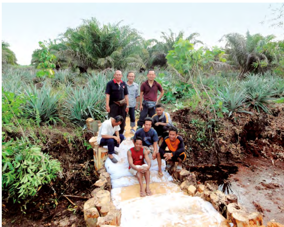
2015年に住民との協働で水路に建設した堰（後列右から甲山さん、水野さん）
