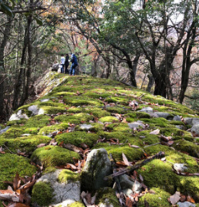
写真1 土砂災害を防ぐための石堤
