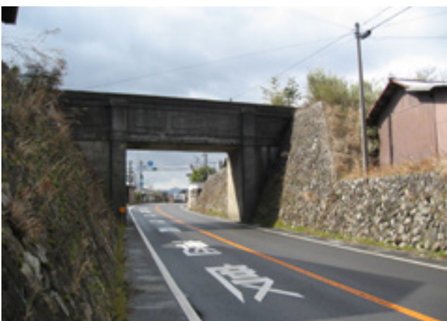
図4 家棟川下流道の上を流れる天井川
