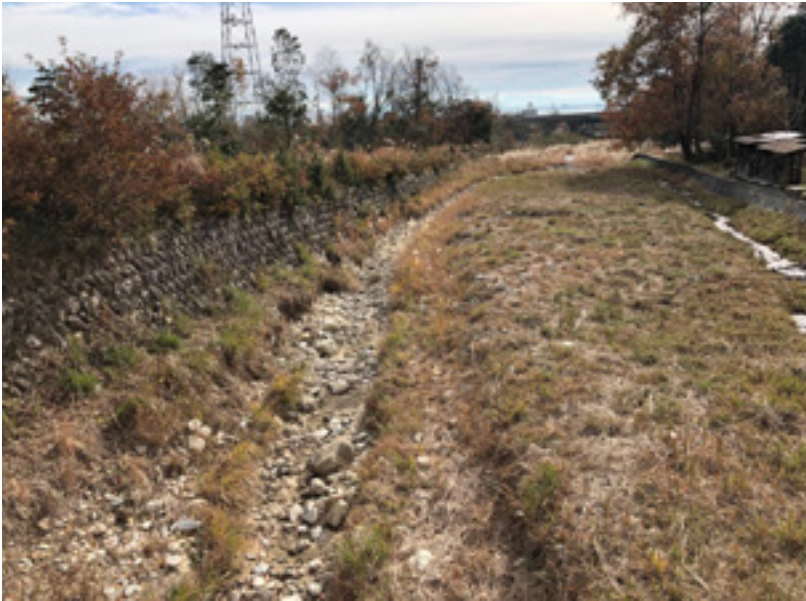
写真5 四ツ子川 石積み堤防
