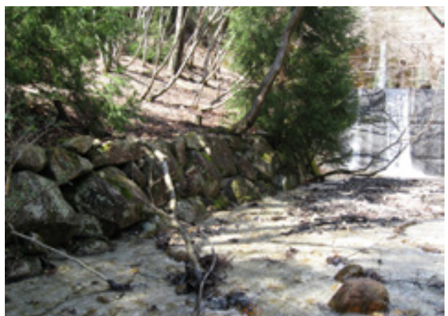
図3 家棟川上流石堤跡と砂防堰堤
