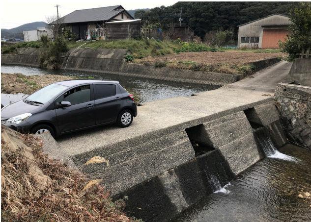
写真10 車両の通行が可能な洗越堰 洗越は、地域の農業や生活を便利にするための渡河施設です。
