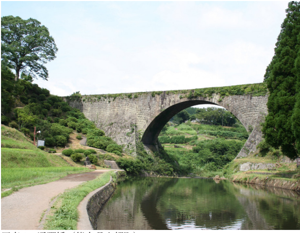
写真3 通潤橋 (熊本県山都町)
