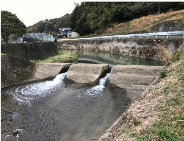
写真5 コンクリート堰
