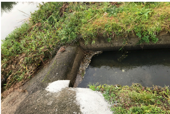
写真6 馬ノ頭野越 越流部がコンクリート張りになっていて壊れにくくなっている
