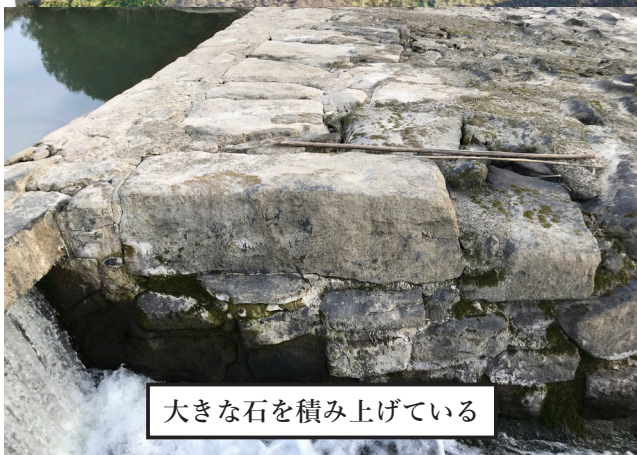
写真1 萩の尾堰の構造
