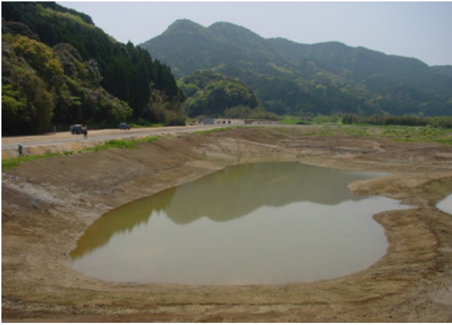
2004年3月 施工直後：写真手前に見える水域は下池。掘削当初は裸地で植生は全く見られない。
