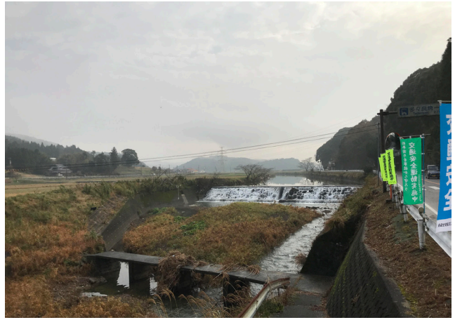
写真6 堰の下流に設けられた沈下橋
