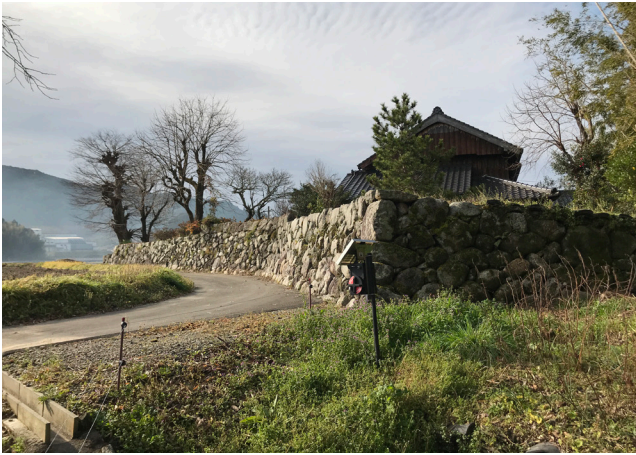
写真4 上流側に設けられた石垣は下流側に行くほど低い
