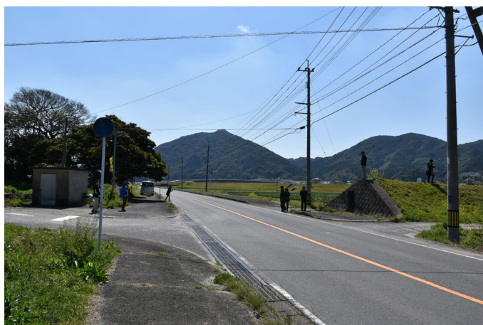
写真3 出水時陸間が設置される県道 (撮影: 田中尚人)
