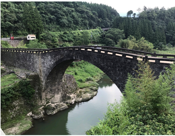
写真1 霊台橋（熊本県美里町）
