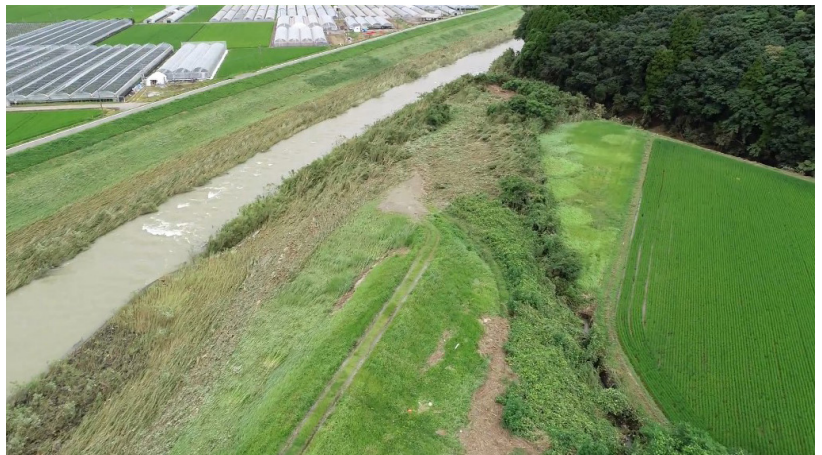
写真5 洪水後の氾濫原霞堤開口部の様子
