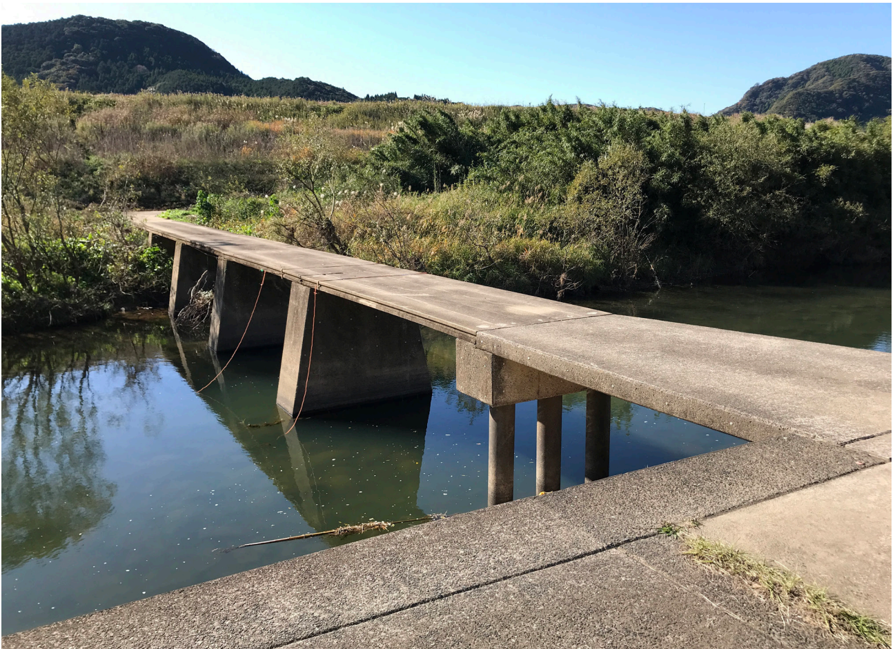
写真5 佐里の沈下橋
