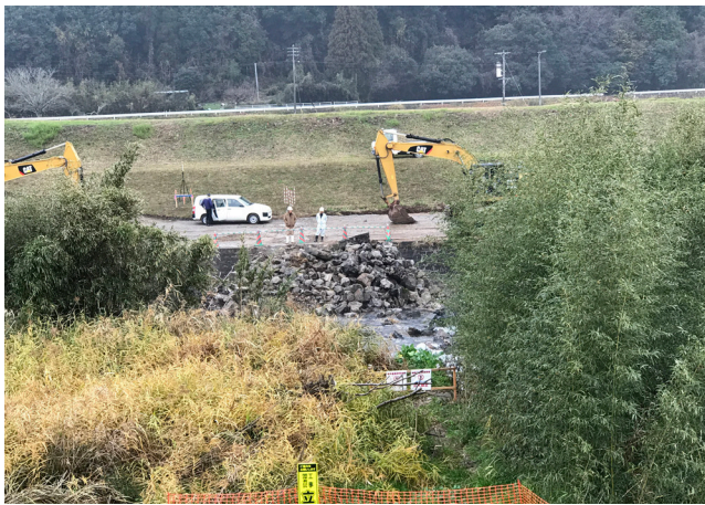
写真3 大川野の沈下橋の撤去作業
