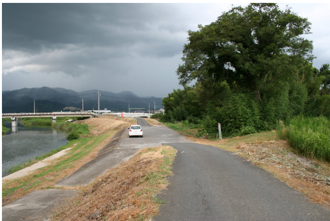
写真7 城原川野越 堤防を一部低くし、任意の場所から洪水を溢れさせる
