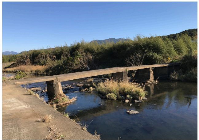
写真2 大川野の沈下橋
