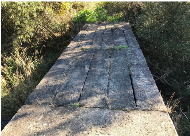
写真4 大川野の沈下橋の一部は石桁であった
