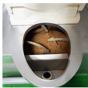
← 地球研に設置されたコンポストトイレ。排泄物をおがくずなどと微生物で分解し、水を使わない。
