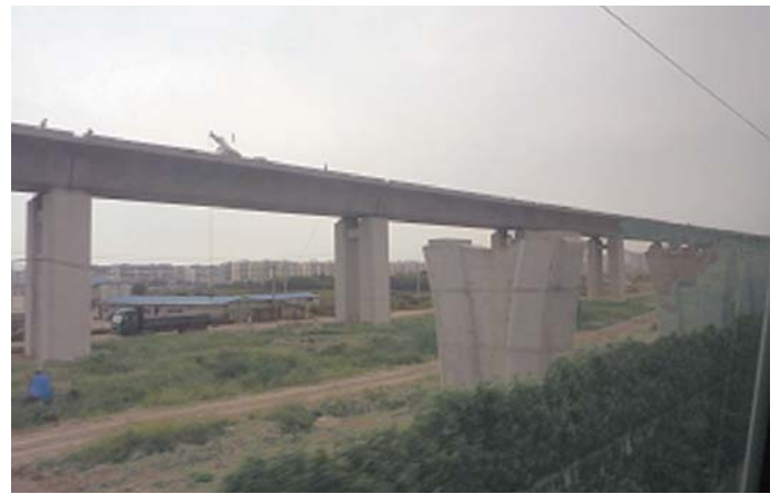
2本の高架を同時建設 (蘇州)
