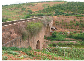
2. 賓川県西平渠の渡槽
