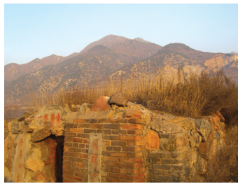
写真2. 水路の入り口
