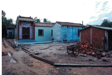
图 2 建設中の農村住居
