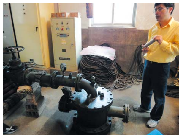
現地調査の様子
