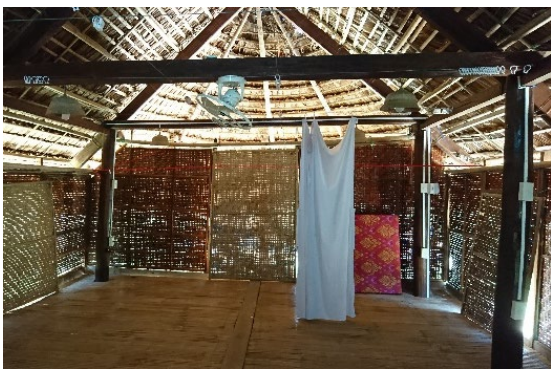
写真③ 2階の宿泊施設
