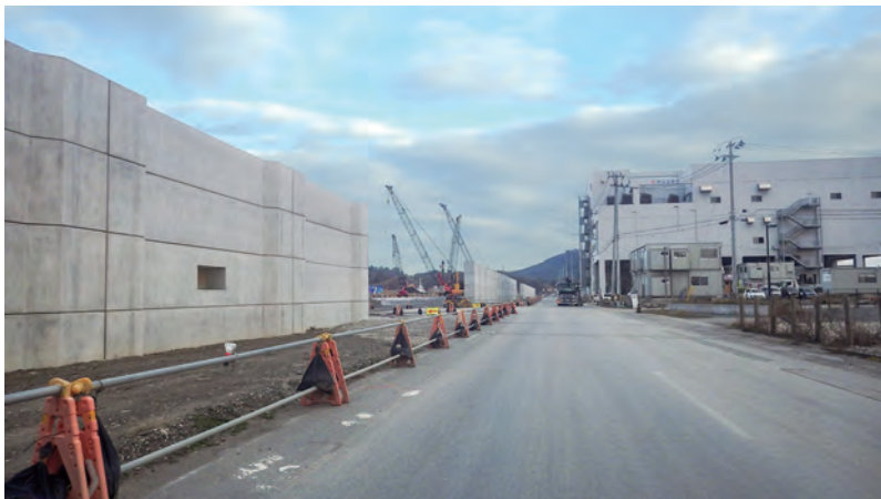
写真6 気仙沼湾の防潮堤
