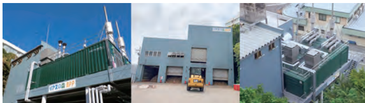
写真1 リアスの森バイオマスパワープラント
