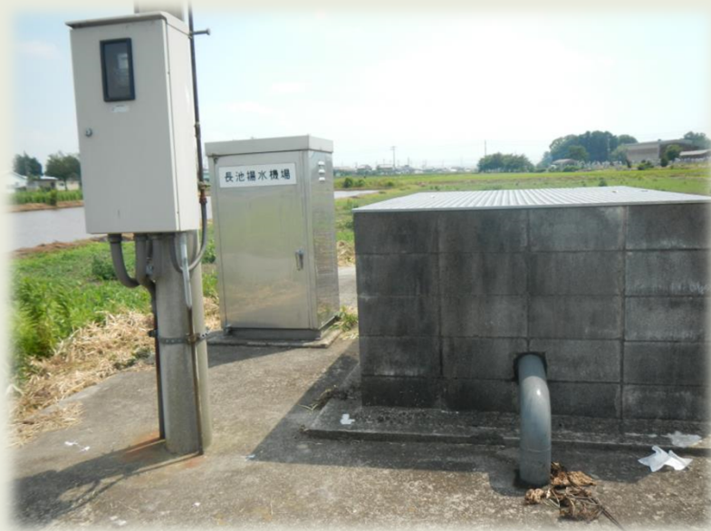
地下水揚水機場
