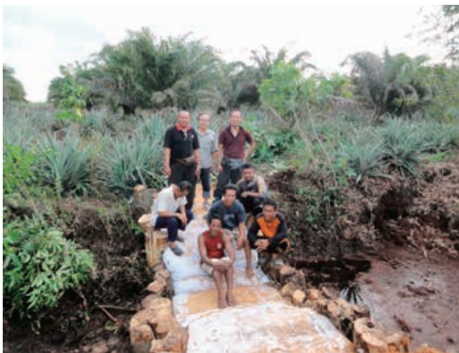
写真5 2015年に住民との協働で水路に建設した堰
