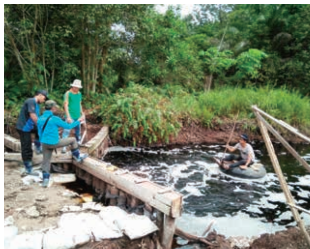
写真1 キャナルブロッキング（CB）と自作ボートによる排水路の測量
