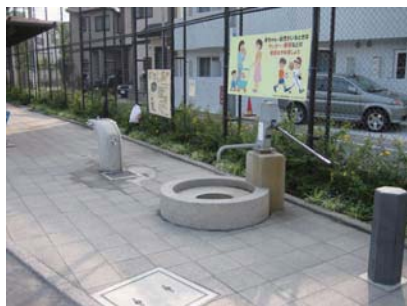
防火・防災井戸(東京世田谷区)
