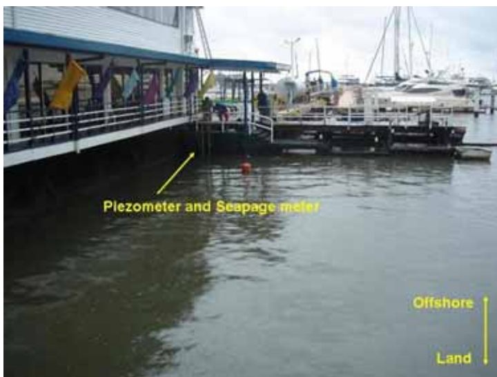
図 2 . 観測機器設置地点
