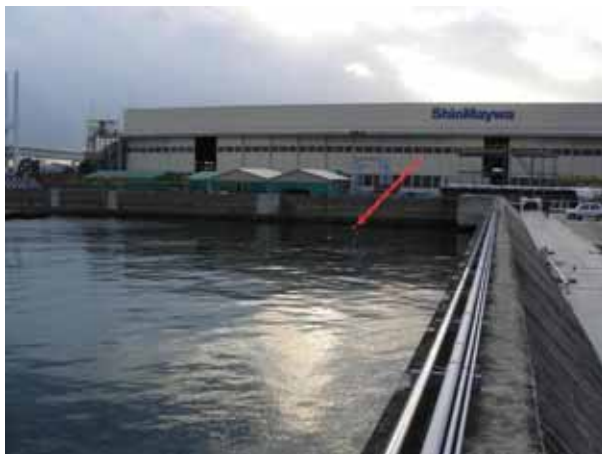
図 4 . 設置現場 2 (赤い矢印の地点に設置) (西向きに撮影)
