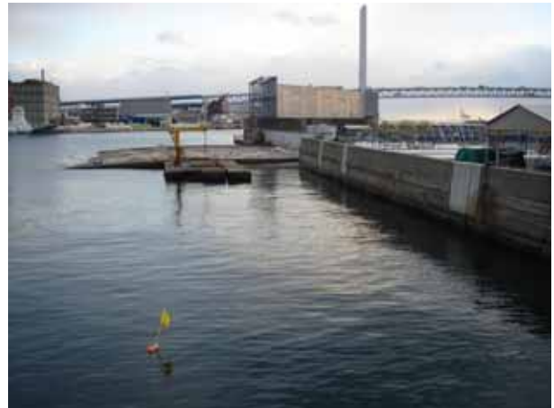
図 3 . 設置現場 (手前の黄色いブイの地点に設置) (南向き (沖方向) に撮影)
