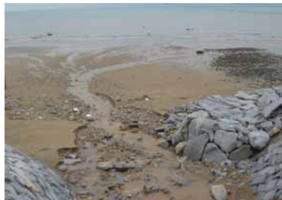
写真 8.護岸斜面の小河川流入
