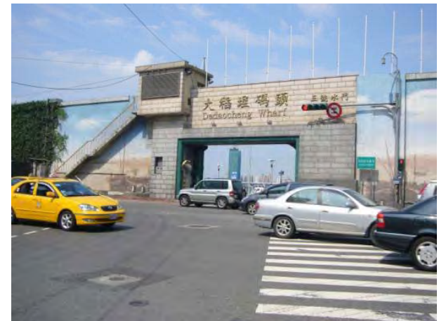
台北淡水河の堤内地と隔てる堤防 (堤防の先は遊覧航路乗り場)
