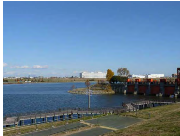
東京・荒川 洪水対策のため人工的に放水路 を掘削
