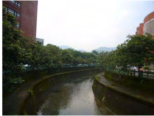
台北郊外・河川 コンクリート護岸の河川
