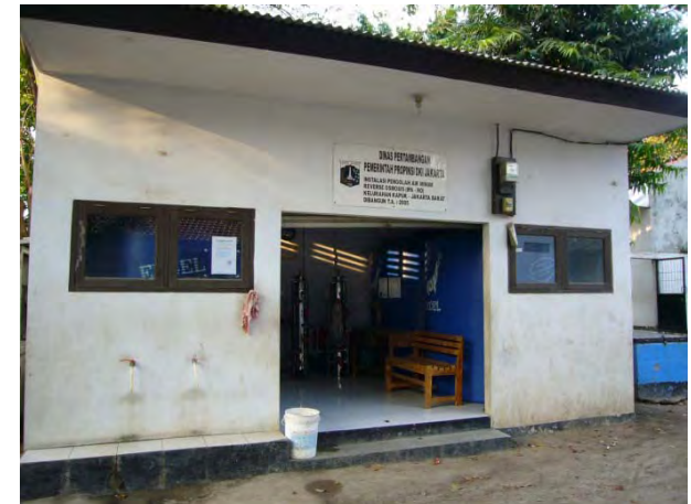
ジャカルタの集落内にある共同の上水道井戸の施設
