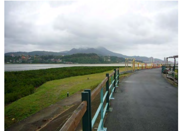
台北淡水河、護岸を遊歩道として 整備
