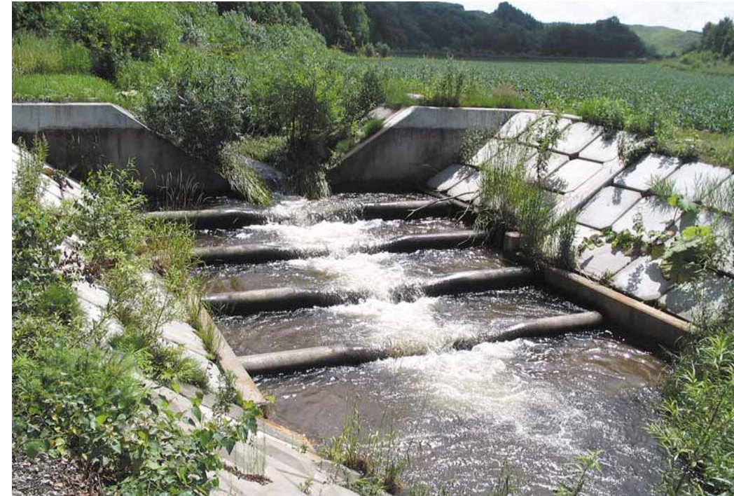
46. 魚類の遡上などの環境に配慮した農地に隣接する落差工 [北海道開発局／美幌町]
