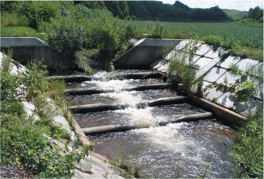
46. 与农地邻接的水利底梁,充分考虑到鱼类溯上河川等环境方面的问题。〔北海道开发局／美幌町〕
