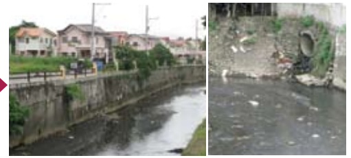
下流域：住宅開発、護岸工事、家庭排水の流入で水質は著しく悪化している
