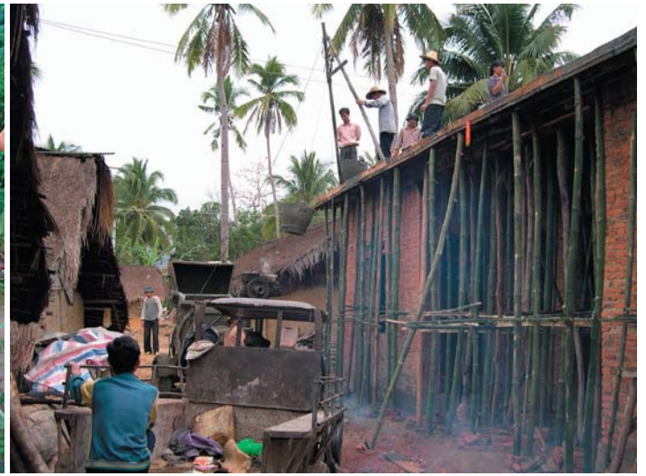
パラゴム栽培のパイオニア世帯が家を建てかえる時の様子 隣りはP村の伝統住居
