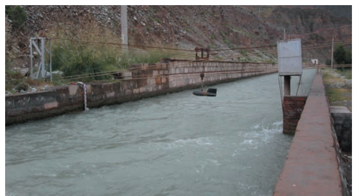
水文観測所の流量観測施設。水路へ取水した量を測定する場所
