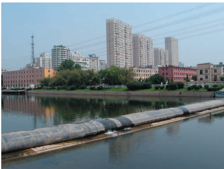
遼寧省大連市馬欄河の汚水処理用ゴムダム (2007年7月撮影)
