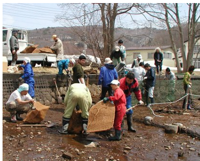
写真：地域住民によるヨシの生育場所（移行帯）の設置
