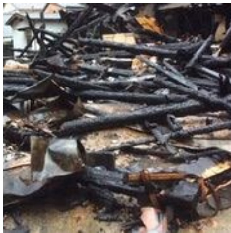
写真①火災の跡
