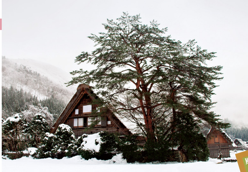
岐阜県白川郷の合掌造り。積雪の重さに耐えられるように屋根がつくられている
