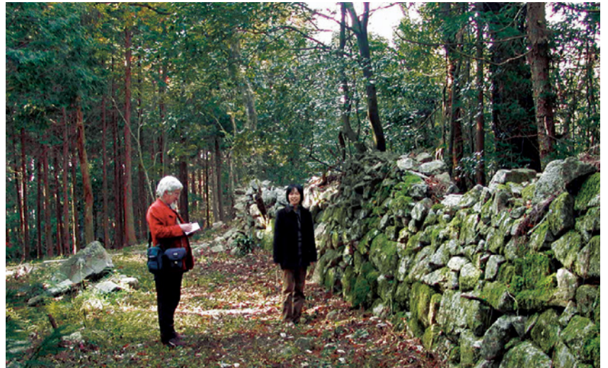
滋賀県比良山麓に残るシシ垣。集落や田畑を獣害から守るとともに、土砂災害も防ぐ働きがあったと思われる
