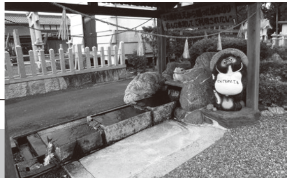
海老江の自噴井（長浜市湖北町） 自噴井からの湧水を三段の水船に流している。飲用などは上流側、洗い物などは下流側を利用するなど、用途によりつかい分けている
