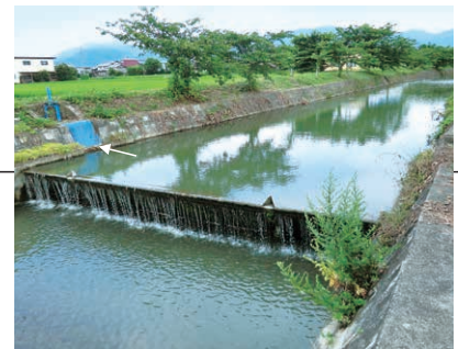
反復利用施設・排水路を堰上げて（少し段差をつけて）、矢印の部分から用水路に流れるしくみになっている
