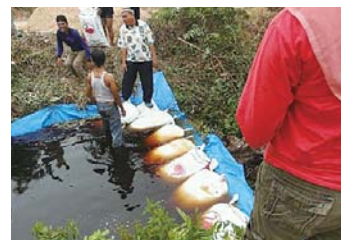
写真 2 火災防止のために本 FS と地域住民が中心になり、泥炭地の排水路に作成した簡易型ダム
