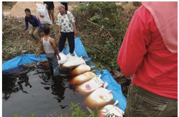
写真2 火災防止のために本FSと地域住民が中心になり、泥炭地の排水路に作成した簡易型ダム
