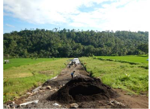
サバ川中流の水田において進む宅地開発（道路を造り、その左右に住宅が建てられます）
