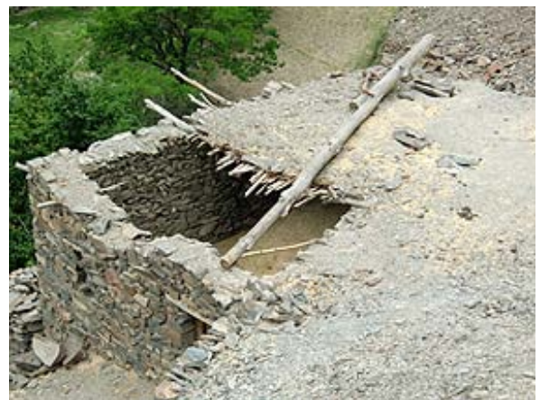
写真3 屋根の資材に使われているDok changのCoppice (2009年8月。野瀬撮影)。
