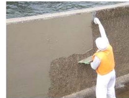
【水路壁の補修による長寿命化】
