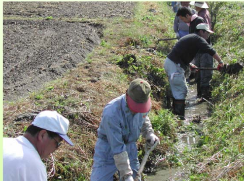
水路の泥上げ
