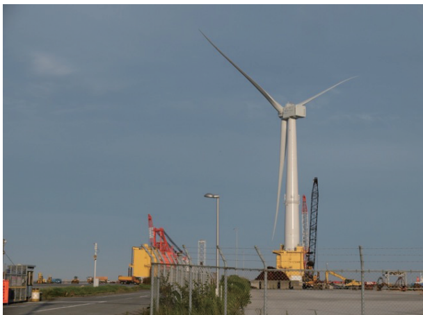
沖合設置を小名浜港で待つ浮体式洋上風力発電実証事業2基目「ふくしま新風」
